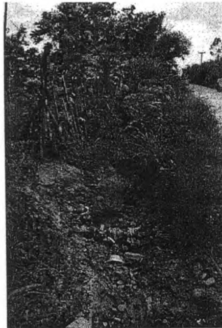
Fotografía 2 (izquierda): Colector 1 en intersección con Arenales, presenta importante vegetación, basura y poca profundidad.
