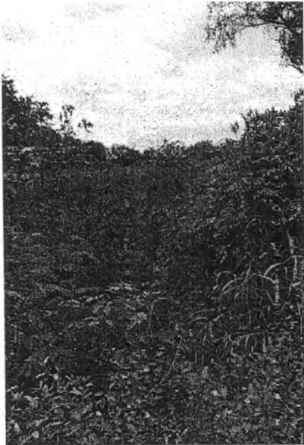
Fotografía 2 (izquierda): Colector 1 en intersección con Arenales, presenta importante vegetación, basura y poca profundidad.
